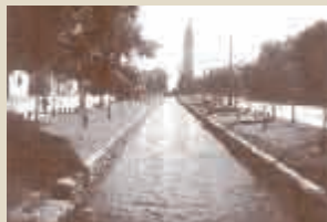
◀ 見せ物小屋があった頃の創成川 (昭和30年頃)
