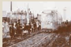
▲北27条～麻生町間延長の開通式(昭和38年)
