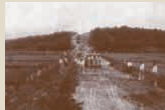
▲アンパン道路の工事(明治44年)
