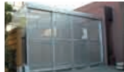
▼新設ゴミステーション
