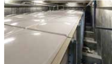
地下に設置されている受水槽
